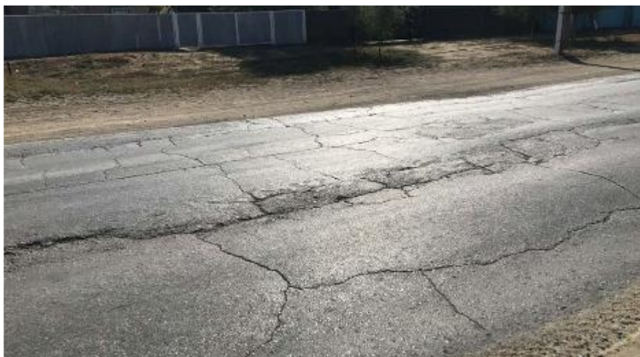
6-сурет: Жарылған жол төсемі, Бестамақ
