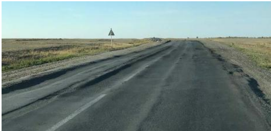
5-сурет: Жол төсеміндегі жолтабандар, шамамен 80 км
